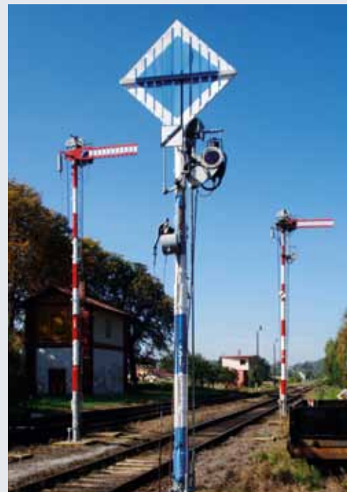
Semafor grupujący Se1. W głębi semafor odjazdowy i wieża ciśnień
