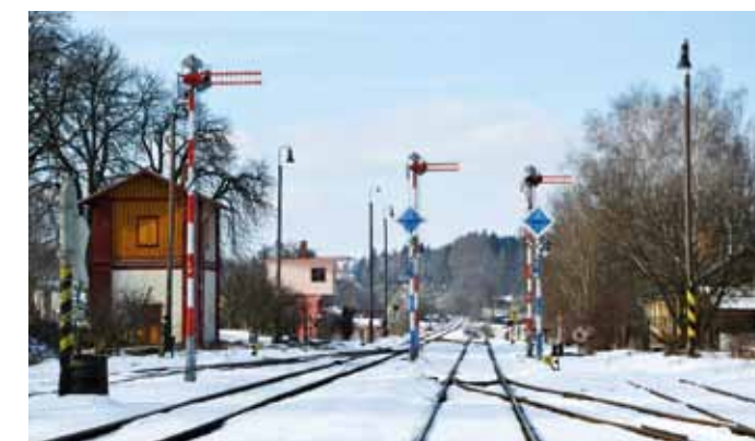
Blick auf die Weichenstraße in Richtung Rostoky/Jilemnice. Im Hintergrund der Stellwerkturnm Stw2
